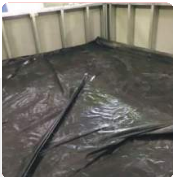
Figura 5: Colocação do filme de polietileno sobre os painéis.
