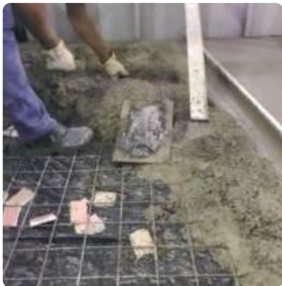
Figura 7: Lançamento do microconcreto do contrapiso.
