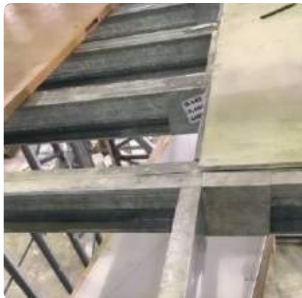
Figura 9: Vista da estrutura do entrepiso formada por vigas de perfis tipo U enrijecidos, guias U simples (viga de borda) e bloqueadores formados por guias U simples.
