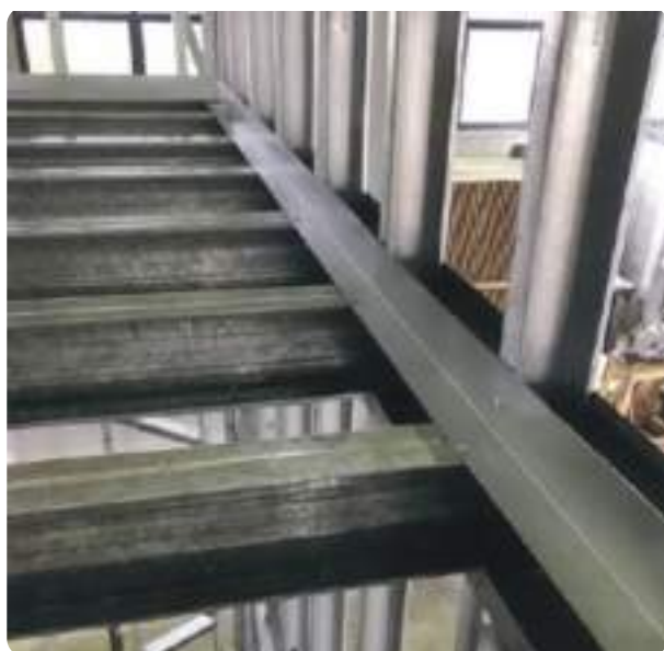
Figura 9: Vista da estrutura do entrepiso formada por vigas de perfis tipo U enrijecidos, guias U simples (viga de borda) e bloqueadores formados por guias U simples.
