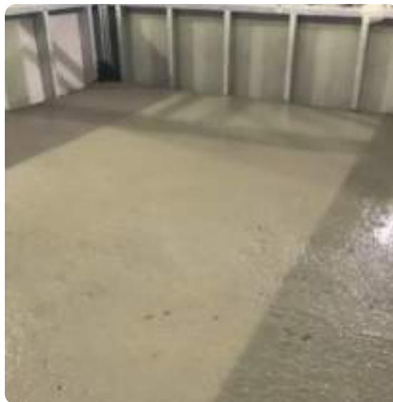
Figura 8: Camada de contrapiso finalizada e acabada.
