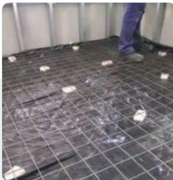
Figura 6: Colocação da tela de aço e dos espaçadores.
